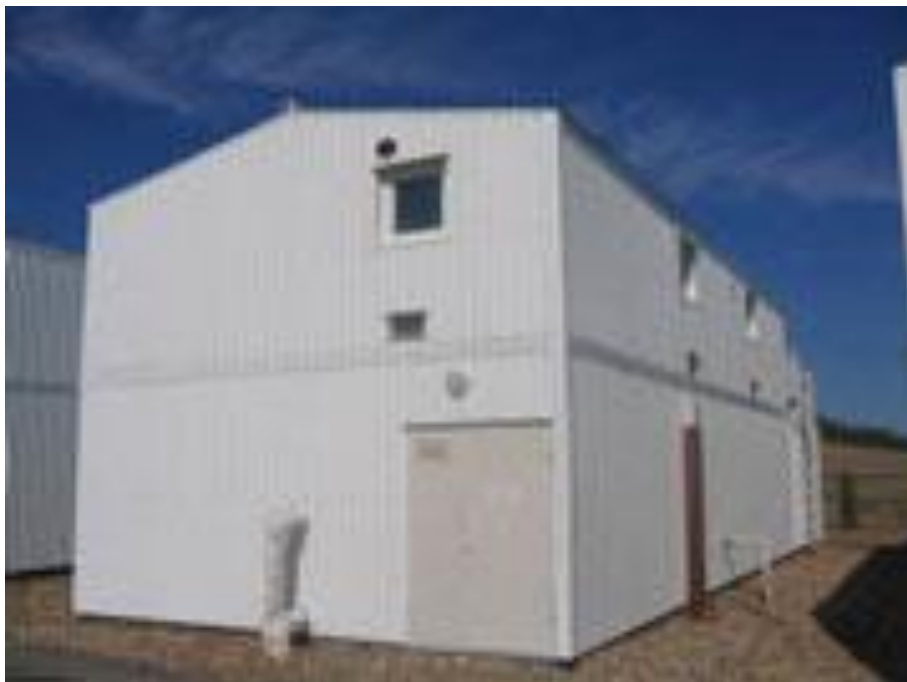
Рис. 13 Внешний вид очистных сооружений «Биоресурс»
